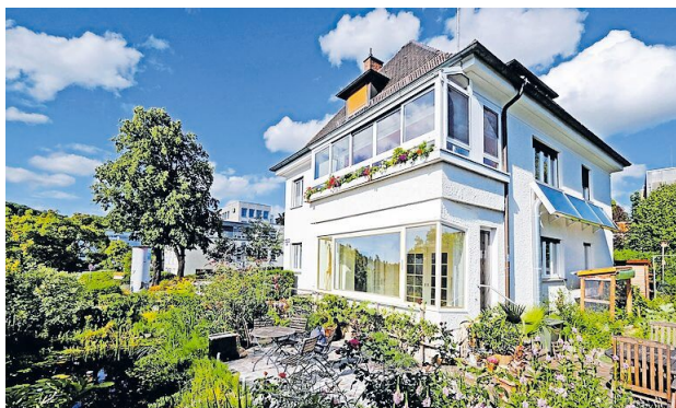
Eine Solarlüftung an der Südfassade sorgt jetzt für ein besseres Raumklima im Keller.
