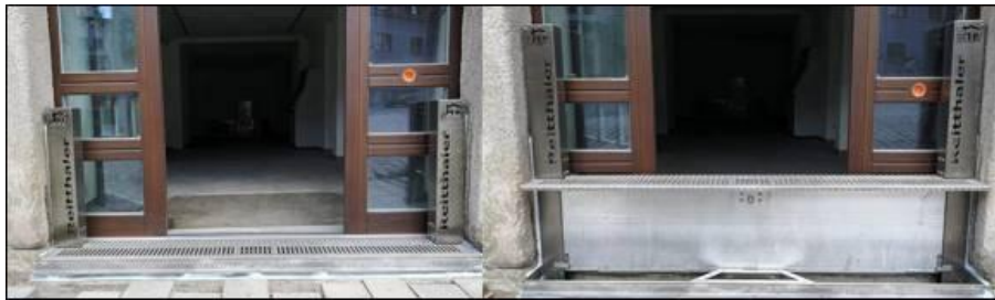
Vertikalschott – Schutzklappe horizontal ausfahrend
