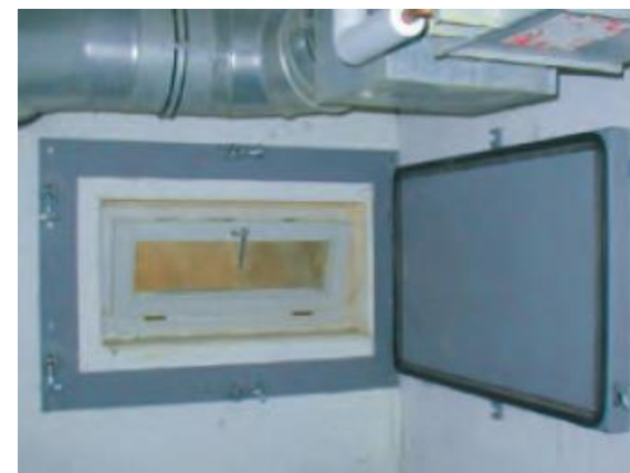
Druckdichtes, selbstschließendes Fenster Leitfaden Starkregen - Objektschutz und bauliche Vorsorge
