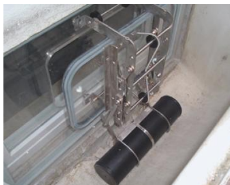
Automatisch schließende Vorsatzscheibe Hochwasserschutzfibel, 2022
