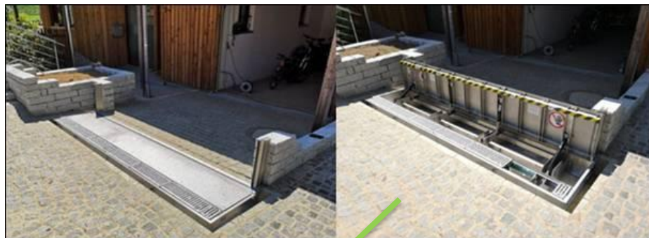
Klappschott – Schutzklappe um 90° aufrichtend
