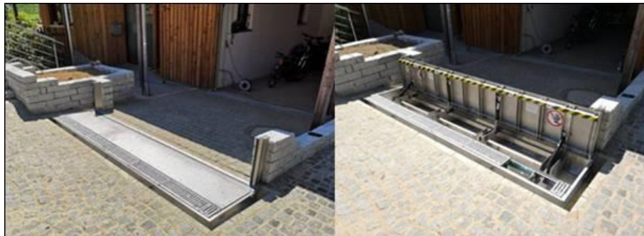
Klappschott – Schutzklappe um 90° aufrichtend
