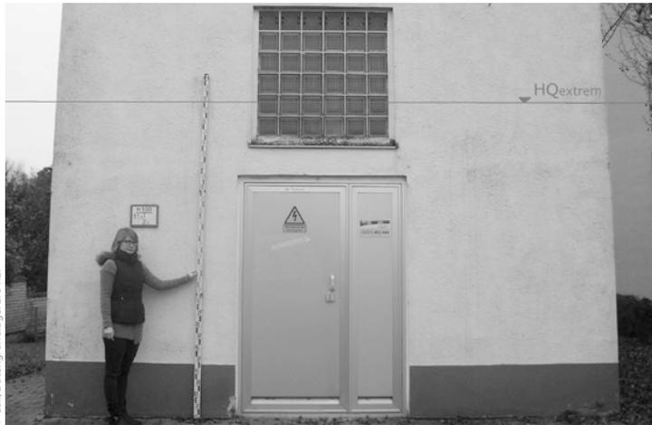
**Bild 2:** Wasserstand über GOK bei einem HQ<sub>extrem</sub> an der Übergabestation der Stromversorgung in Bobenheim-Roxheim
